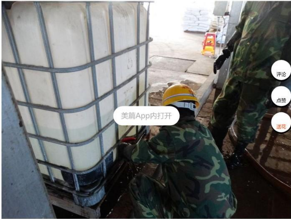
应急人员封堵泄漏点
