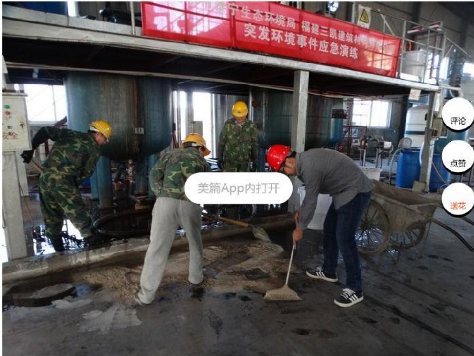
吸附处置泄漏现场母液
